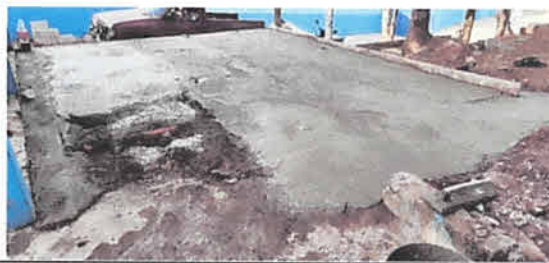
Foto 4: sustitución de torta en mal estado.
